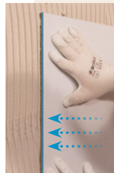
Kondensat aus der Raumluft wird gepuffert
