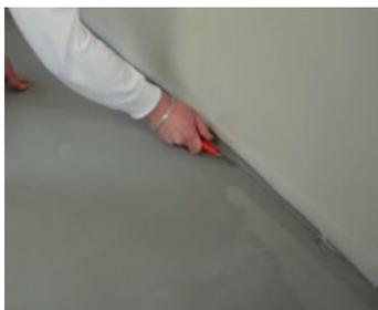
Randdämmstreifen oberflächenbündig mit Cupschnittmesser durchschneiden und entfernen.
