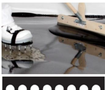
Floortec 2K-Mineralico SL 470 im Raketverfahren verteilen. Flächen stets vollständig abrakeln und Materialanhäufungen vermeiden.
