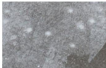
Vorhandene Poren mit Fassaden-Glättspachtel F 1539 verschließen.
