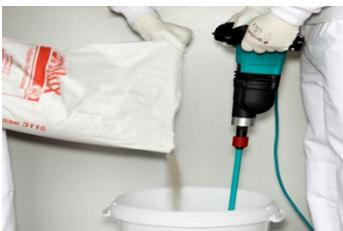
Fußboden-Nivelliermasse C15 3116 oder Fußboden-Nivelliermasse FX 3109 knollenfrei mit geeignetem Rührwerk und Rührstab ansetzen. Vorzugsweise den Collomix Mörtelrührer DLX 152 HF 3347 verwenden.
