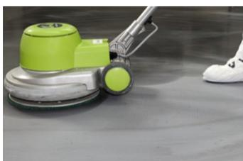
Fläche mit Einscheiben-Schleifmaschine und grünem Pad polieren. Schwer zugängliche Bereiche, Kleinflächen und Innenecken können alternativ mit der Rotex oder von Hand mit dem grünen Pad poliert werden.
