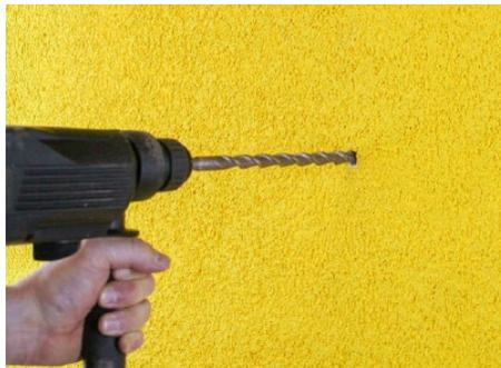
Montageobjekt mit Schraubdübeln im Mauerwerk verankern. Die Durchdringungen sind so abzudichten, dass kein Wasser in das WDV-System eindringen kann.
