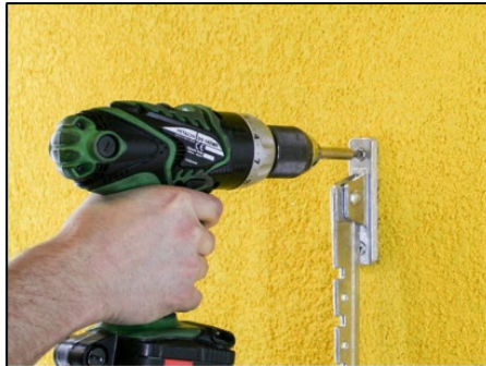
Montageobjekt im EPS Montagezylinder 3844 verschrauben.
