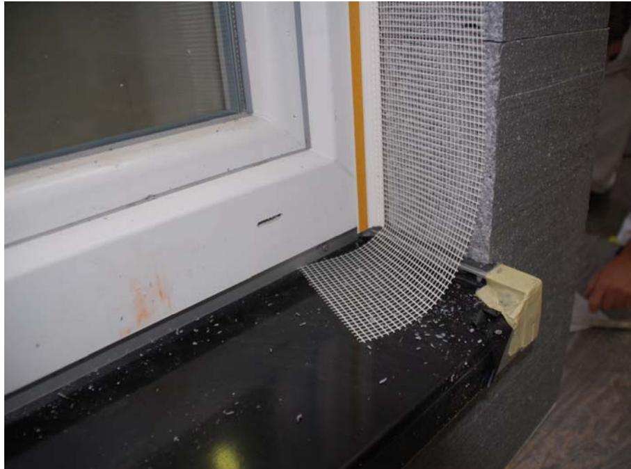
**Bild 3** Brillux WDVS Gewebe-Anputzleiste 3707, Ausbildung Übergang zur Fensterbank.
