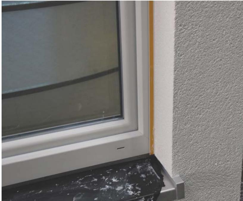
**Bild 5** Ausbildung des Übergangs zur Fensterbank nach fertig gestelltem WDVS.
