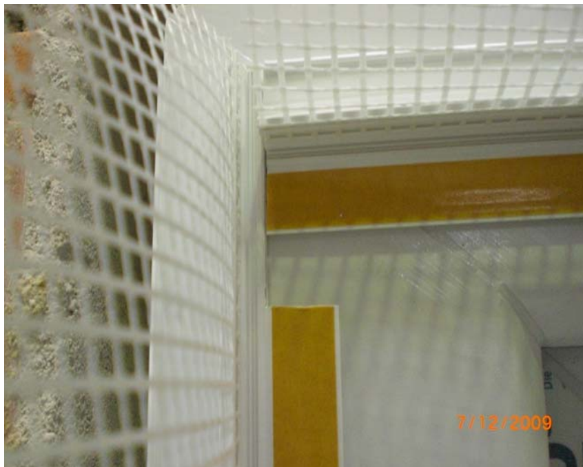
Bild 2 Brillux WDVS Gewebe-Anputzleiste ZF 3820, Eckausbildung oben.
