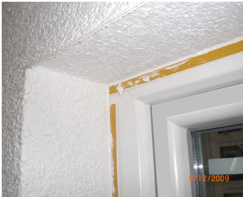
Bild 6 Oberer Eckbereich nach fertig gestelltem WDVS.
