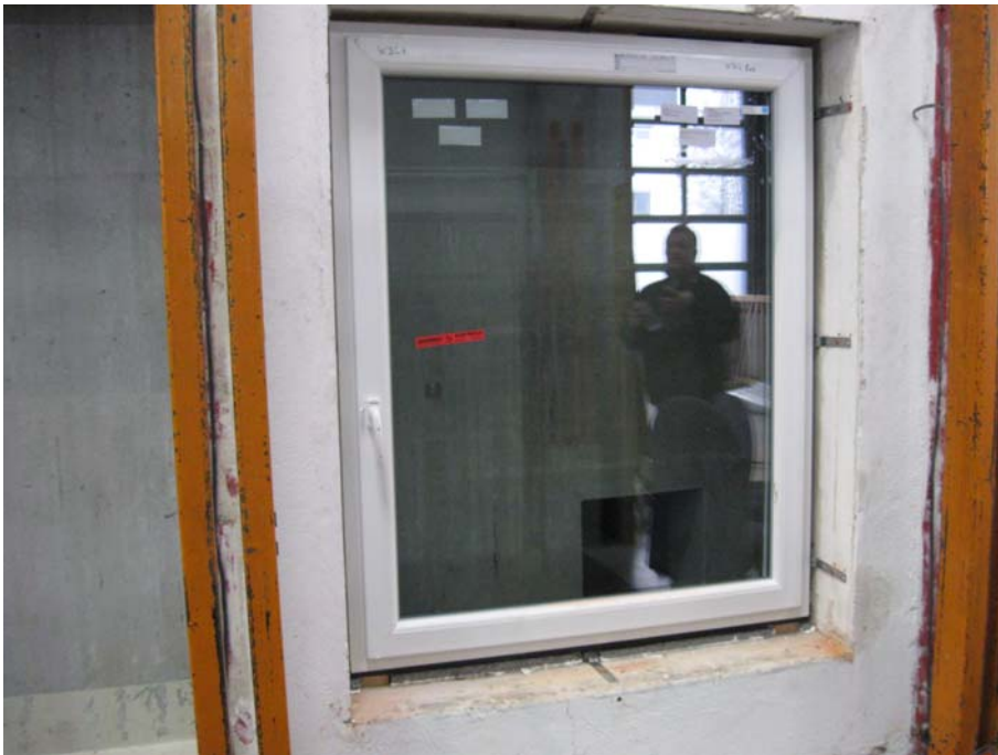
Bild 1 Probekörper Bauteilprüfung, Ansicht von der Raumseite
