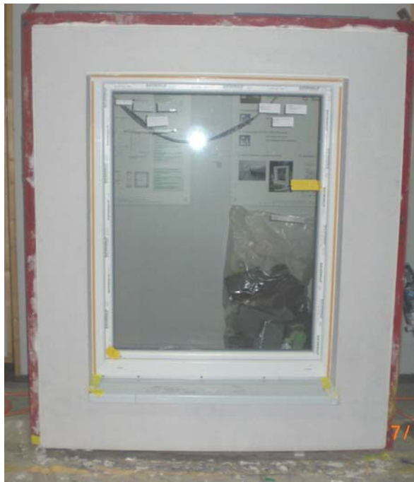
Bild 4 Probekörper mit ausgeführtem Armierungsputz.
