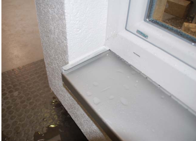
Bild 5 Ausbildung des Übergangs zur Fensterbank nach fertig gestelltem WDVS.
