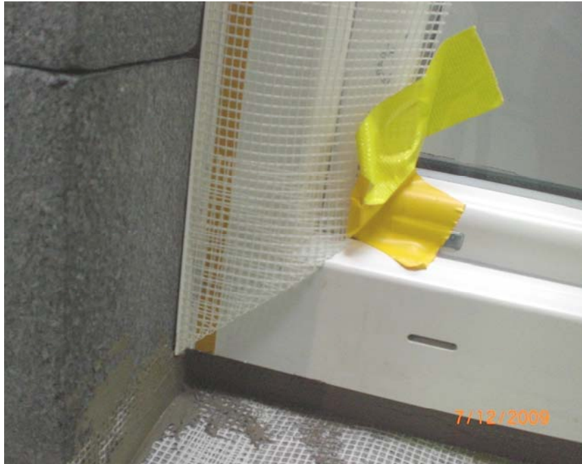
Bild 3 Brillux WDVS Gewebe-Anputzleiste ZF 3820, Eckausbildung unten.
